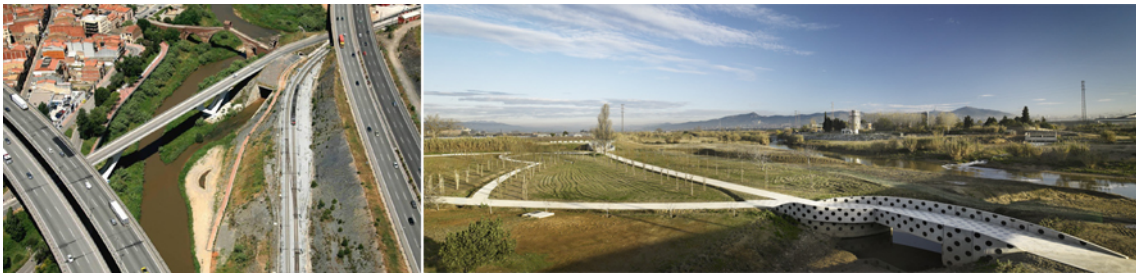
Intervencions supramunicipals: recuperació mediambiental de l'espai fluvial del riu Llobregat a la comarca del Baix Llobregat.
