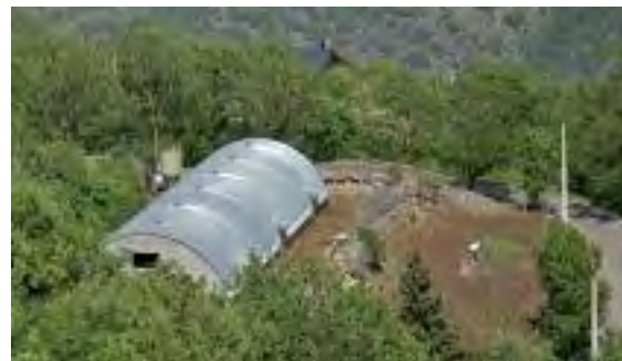
Ubicar la construcció en la massa boscosa i allunyar-la de la part visualment més exposada de la parcel·la són recursos que n'atenuen la presència des de la carretera.
