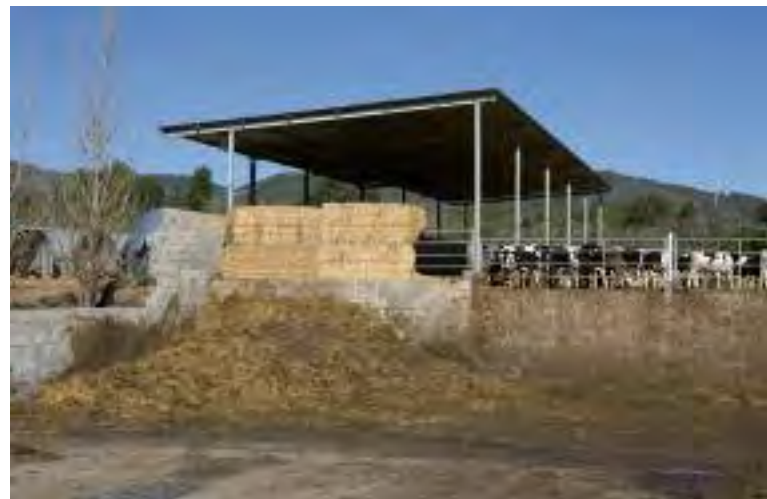
Els femers mig soterrats i propers a les naus ramaderes són pràctics i funcionals alhora i l'impacte visual que generen es minimitza perquè queden amagats.
